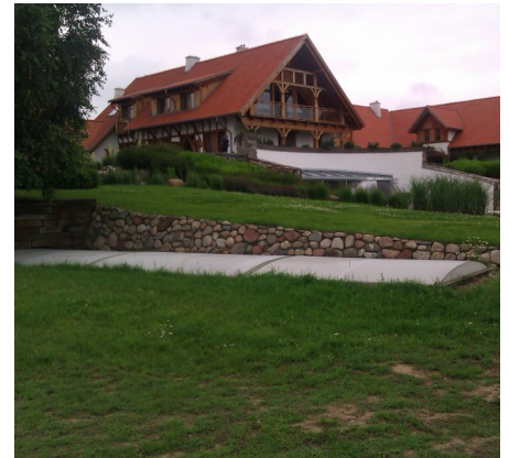
Sistema Júpiter instalado en un Hotel
